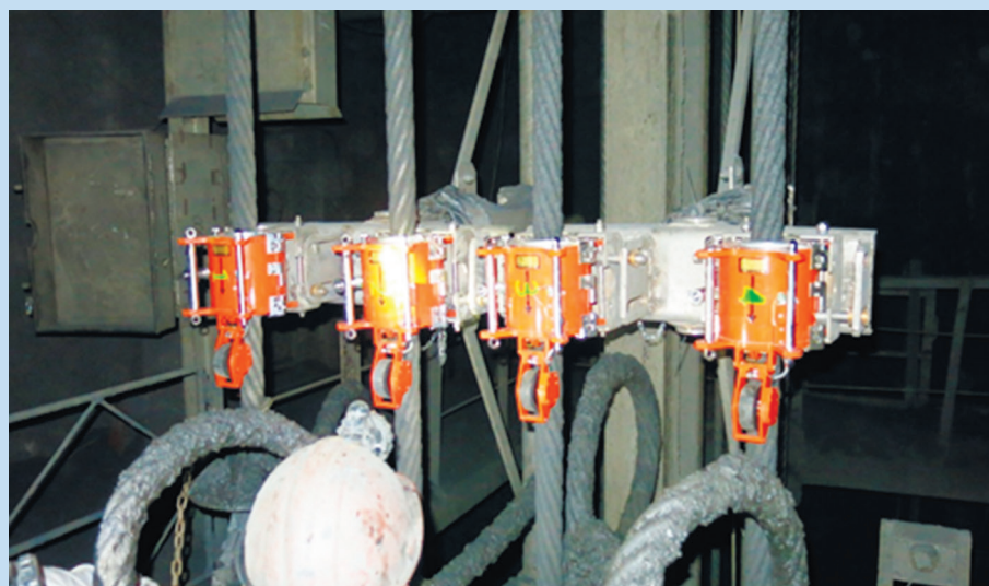
Рис. 3. Навеска МГ при одновременном контроле четырех канатов на отметке 22 м.
